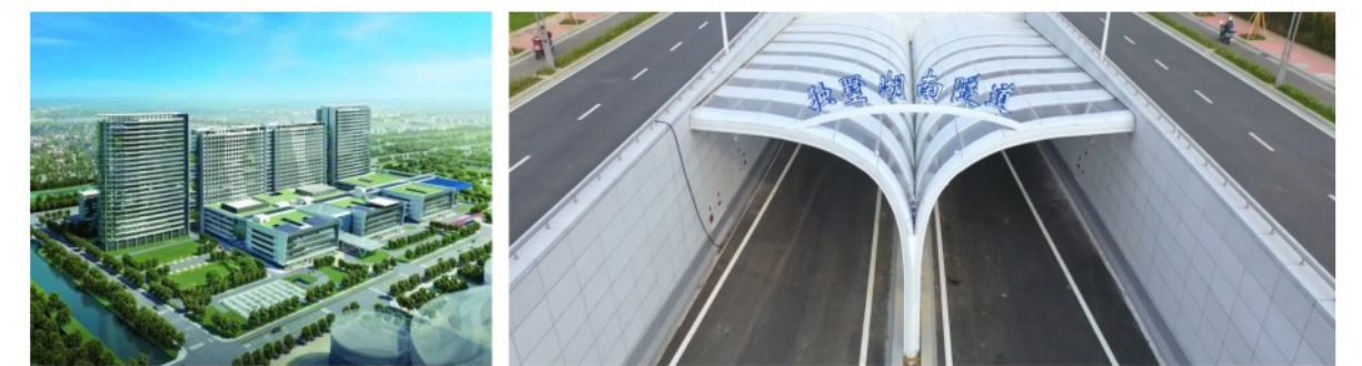
苏大附一院综合楼 独墅湖南隧道
